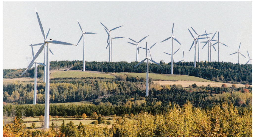
Parc d'éoliennes au Bas-Saint-Laurent
