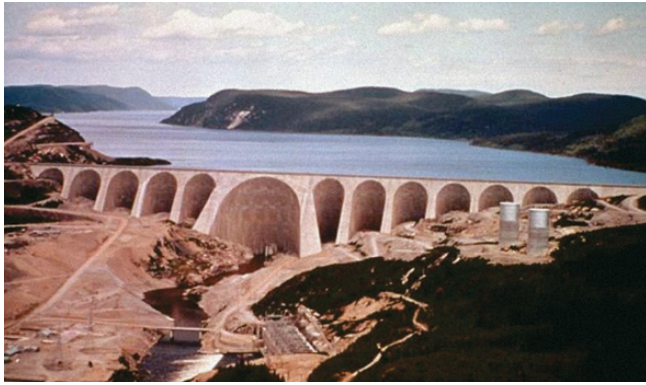
Barrage hydroélectrique Manic 5 Le monde en images, CCDM
